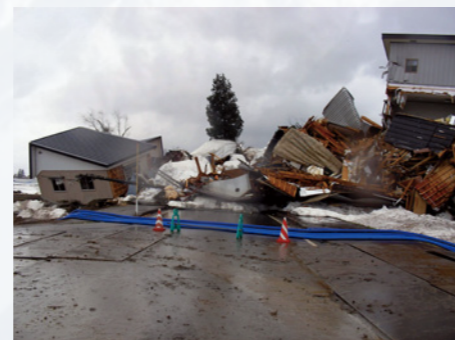
融雪水による地すべりで破壊された家屋 A meltwater-induced landslide surged into a local hamlet.
