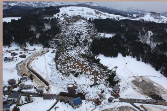
融雪地すべりによって破壊された集落(新潟県砂防課提供) A meltwater-induced landslide swept away a hamlet (courtesy of Niigata Pref. Govt.)
