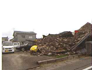
2007年新潟中越沖地震発生による 柏崎市の建物被害
