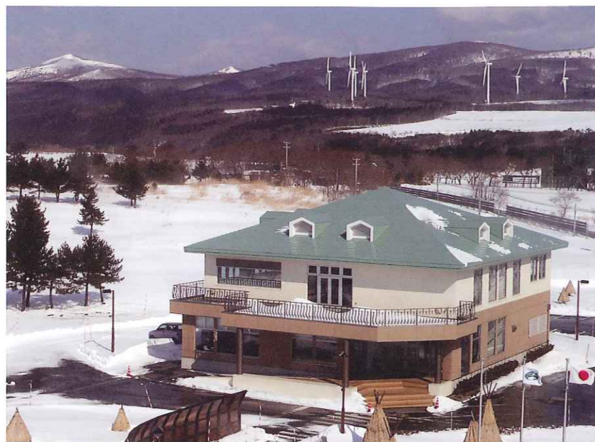
六ヶ所原燃PRセンターから見た原子燃料サイクル施設
