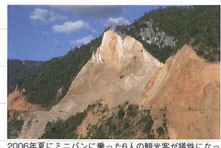
2006年夏にミニバンに乗った6人の観光客が犠牲になった、中国雲南省に新しく建設された道路の切土斜面に沿って生じた巨大な地滑り A large landslide that occurred along the cutslope of this newly constructed road in Yunnan, China that killed six people traveling in a minivan in summer 2006
